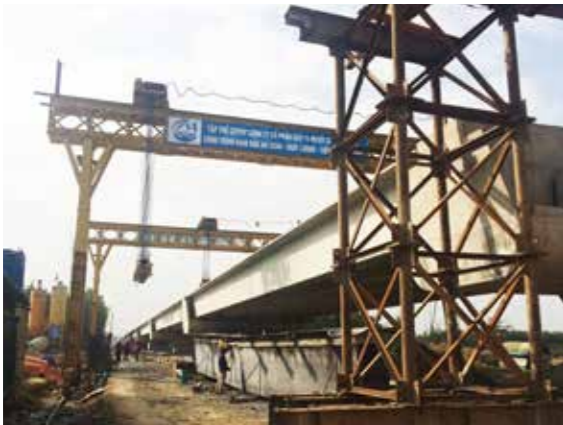
Xe lao lắp dầm SuperT
