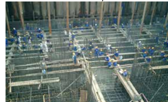
Thi công BTCT bộ trụ P23 cầu Thanh Trì
