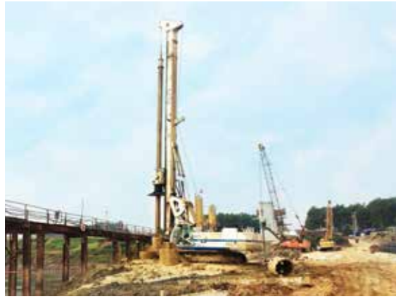
Khoan cọc nhồi SOILMEC
