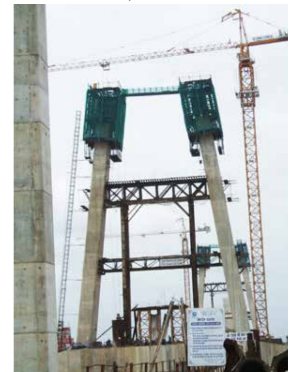
Ván khuôn leo thi công thân trụ tháp cầu Rạch Miễu
