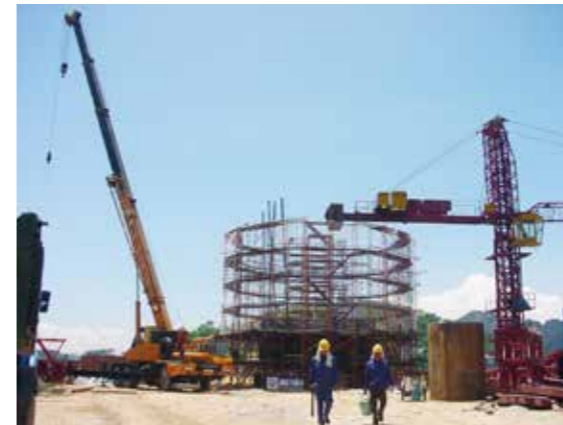
Thi công giếng chìm trụ chính cầu Bãi Cháy
