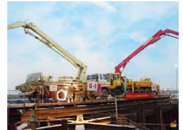
Xe bơm bê tông
