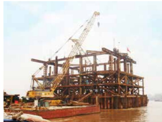
Hệ khung vây, khung tời thi công trụ dưới nước
