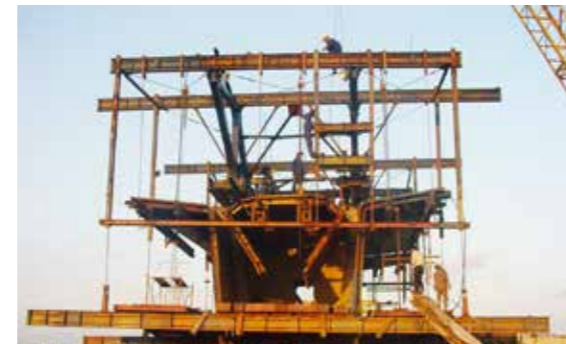
Xe đúc dầm đúc hẫng cân bằng
