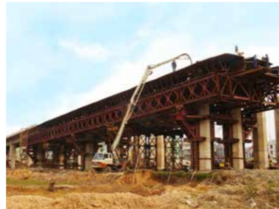
Thi công dầm trên đà giáo gói thầu BC3 Bãi Cháy
