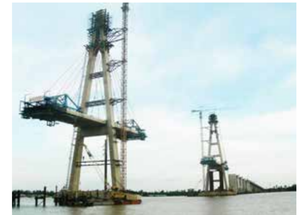
Thi công dầm đúc hẫng cầu Rạch Miễu
