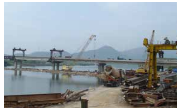
Sản xuất và lao lắp dầm I, L=33m
