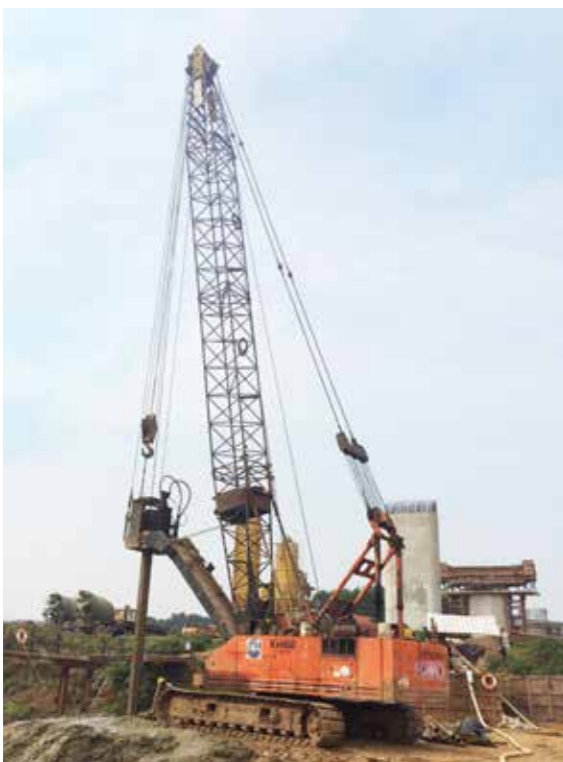
Khoan cọc nhồi RT3 ST
